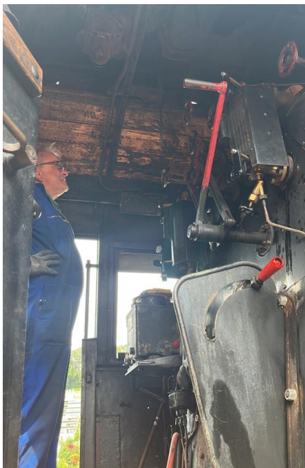
Strahlende Gesichter beim Blick auf das Kesselmanometer beim Einstellen der Sicherheitsventile durch den SVTI.
